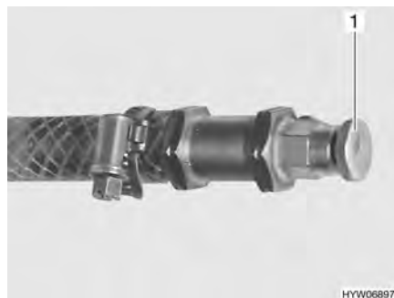
Billede 248 Udluftningsventil varmtvandsvarmeovn
