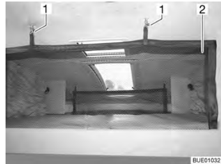
Billede 101 Hejseseng med opspændt sikkerhedsnet
