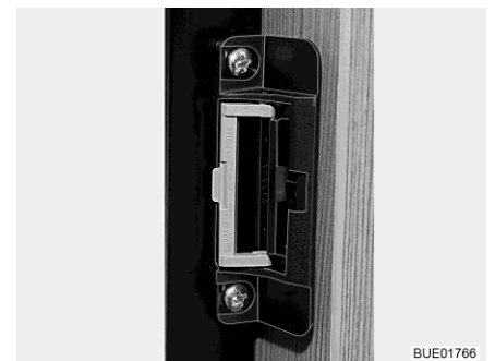
Kuva 90 Lukituslaitteisto tuuletusasennossa
