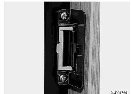
Bild 90 Verschlusseinrichtung in Lüftungsstellung
