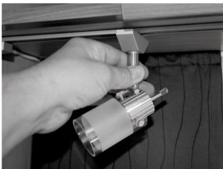
Fig. 140: Cambiar de lugar los focos LED
