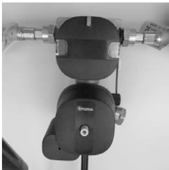
Fig. 79: Suministro de gas (con Eis-Ex e indicación a distancia)
