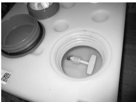
Fig. 99: Bundprop i drikkevandstanken
