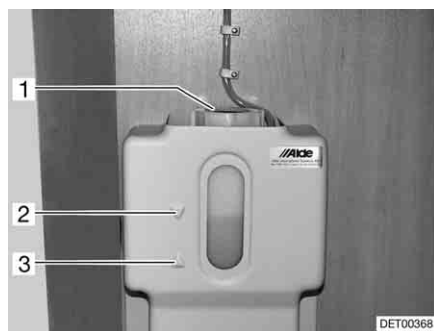
Fig. 235 Vase d'expansion pour le chauffage à eau chaude
