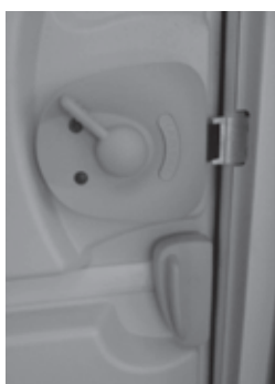
Fig. 17: Leva in alto, serratura della porta bloccata
