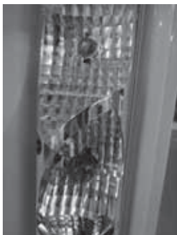
Fig. 155: Sostituire i corpi illuminanti
