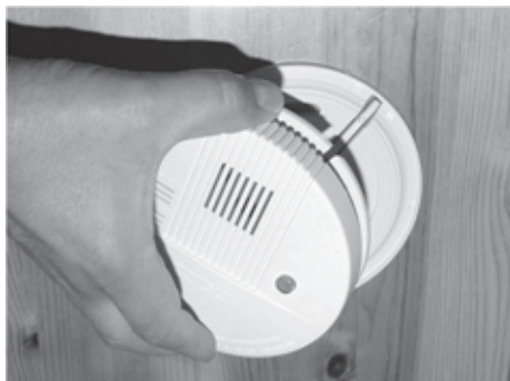
Fig. 100: Togliere l'alloggiamento
