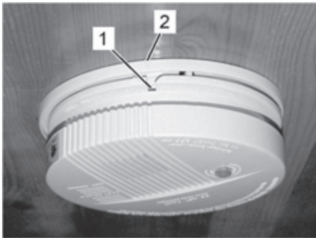
Fig. 102: Sett huset på plass
