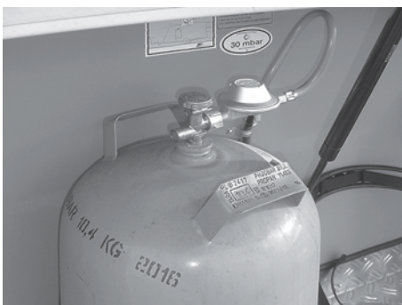
Abb. 92: Gasflasche mit Druckminderventil
