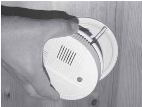
Abb. 93: Gehäuse abnehmen
