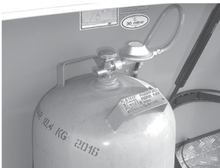
Abb. 69: Druckminderventil
