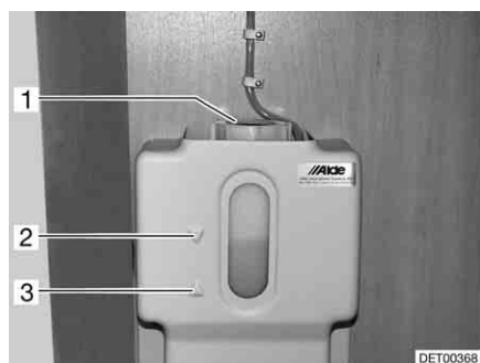
Billede 212 Udligningsbeholder med blænde
