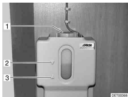
Fig. 212 Vaso d'espansione con diaframma
