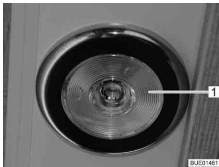
Bild 45 Infälld lampa, ljusbrytare i lampan
