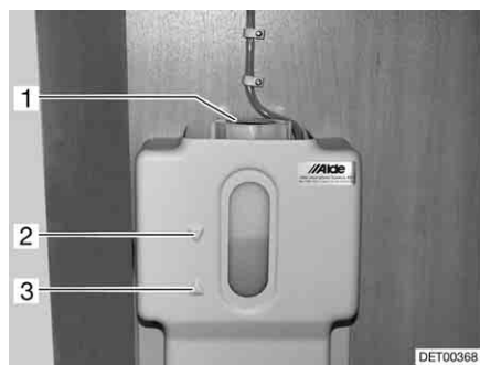
Bild 212 Expansionsbehållare med kåpa
