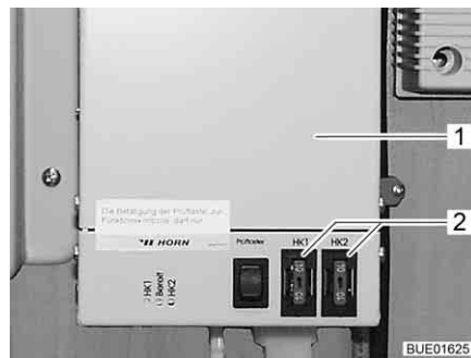
Afb. 130 Regelaar verwarming voor afvalwaterleidingen
