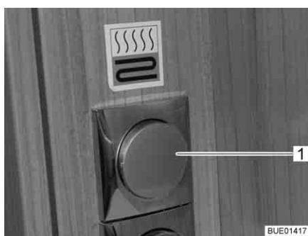
Bild 119 Brytare för golvvärme i toaletterummet
