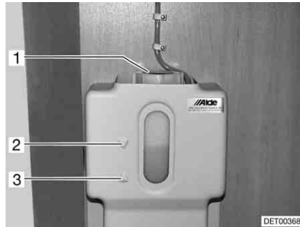
Bild 195 Ausgleichsbehälter Warmwasser-Heizung
