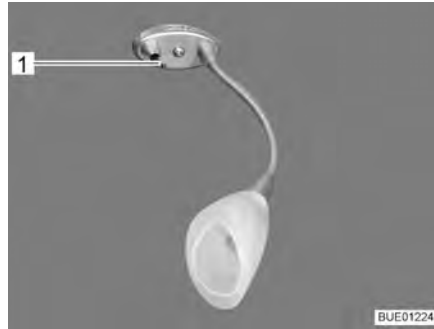
Fig. 45 Illuminazione del vano WC, interruttore luci in corrispondenza della lampada
